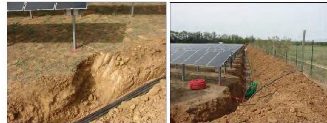
Tranchée drainant le courant continu
