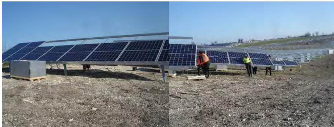
Pose des modules, centrale solaire du Sycala (46)
