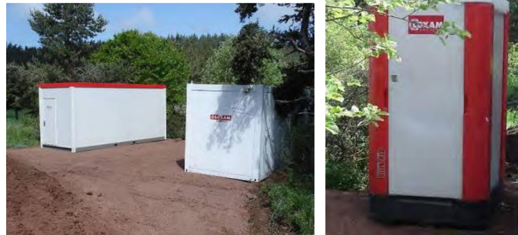
Vestiaires et bureaux de chantier et exemple de sanitaires
