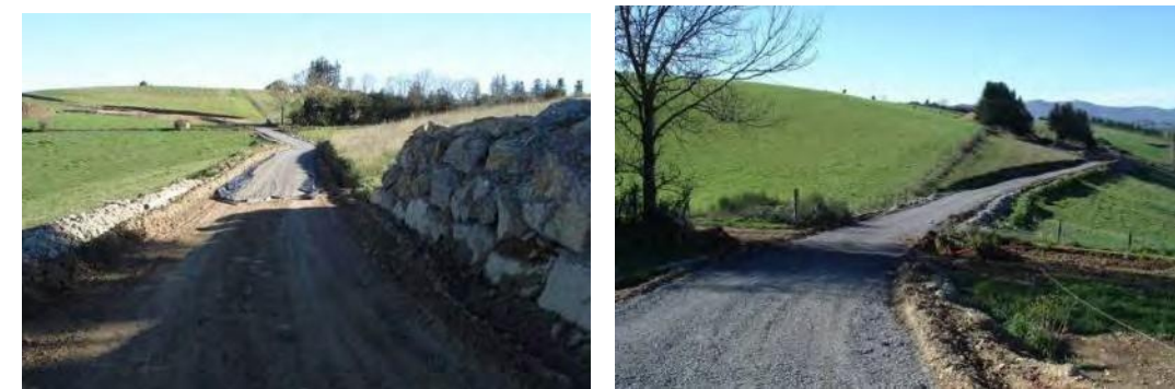
Mise en place de matériau d'emprunt (cas d'un parc éolien)
