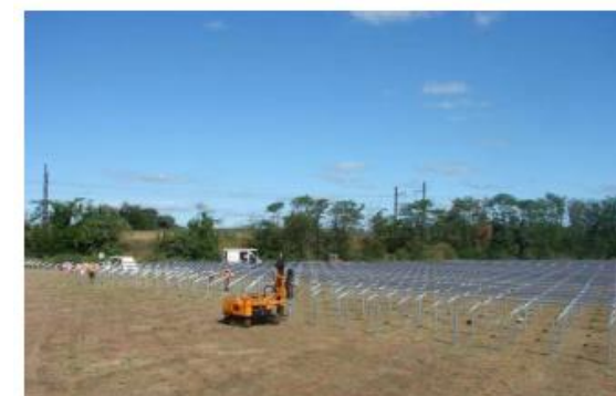
Battage des pieux
