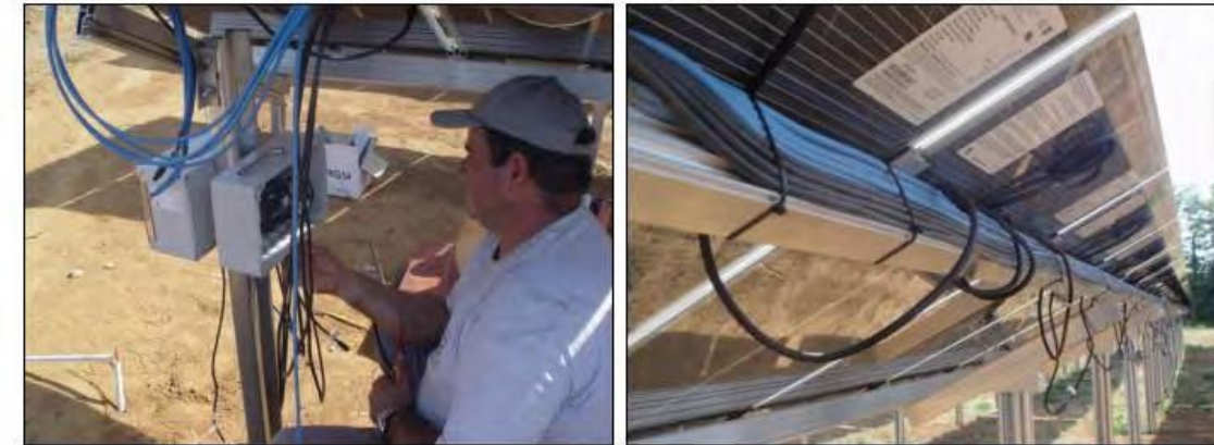
Mise à terre (protection directe)
