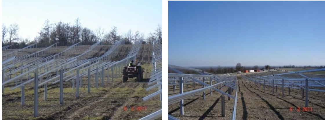
Fixation des adaptateurs et fixation des rails de support
