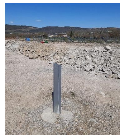
Exemple de pieux forés bétonnés
