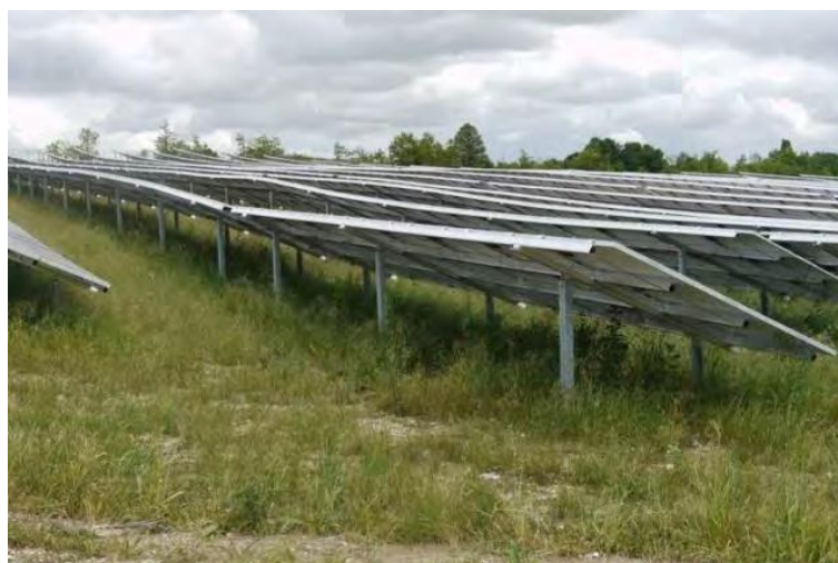
Re végétalisation, 1 mois après les travaux, centrale solaire du Sycala (46)
